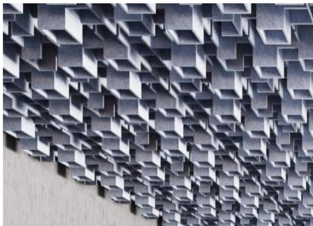
Los techos Cúbico, diseñados para el medioambiente, su fabricación está basada en un bajo consumo de energía y están hechos de fibra poliéster totalmente reciclada. Han sido diseñados para el desmontaje, con todos sus componentes para ser fijados sin adhesivos o colas. El techo Cúbico es a su vez reciclable.
